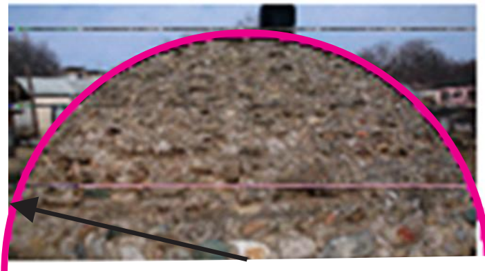
Şəkil 6. Vənənd kənd hamamı. Günbəzin quruluşu
