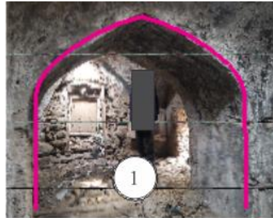
Şəkil 5. Vənənd kənd hamamı. Daxildə çatma tağ ayriləri
